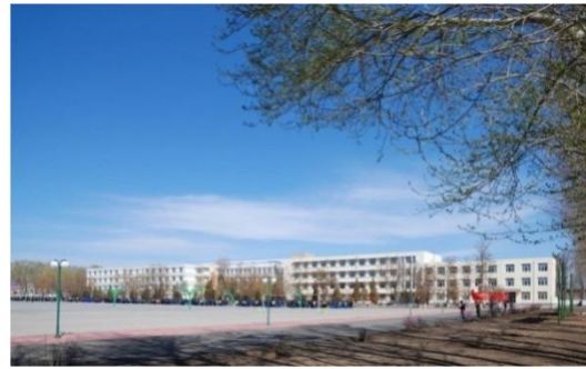
学校操场全景
